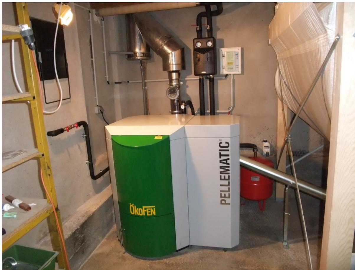
*Chaudière granulés de bois de marque Okofen d'une puissance de 20kW en remplacement d'une chaudière fioul. Alimentation automatique par vis à partir d'un silo de 6 tonnes.*
