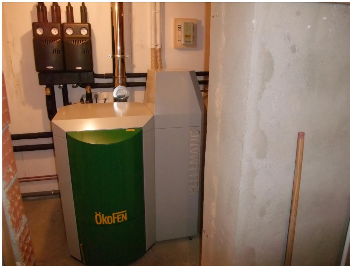
*Chaudière granulés de bois de marque Ökofen d'une puissance de 15kW en remplacement d'une chaudière fioul. Alimentation automatique par aspiration à partir d'un silo de 4.8 tonnes. Elle assure également la production d'eau chaude sanitaire avec un ballon d'une capacité de 300 litres.*
