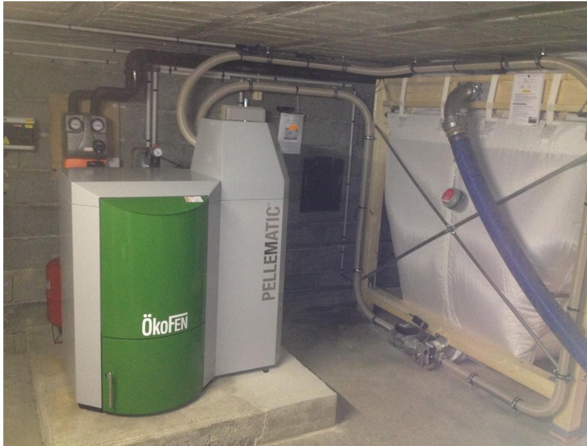
*Chaudière granulés de bois de marque Okofen d'une puissance de 20kW en remplacement d'une chaudière fioul. Alimentation automatique par aspiration à partir d'un silo de 5 tonnes.*
