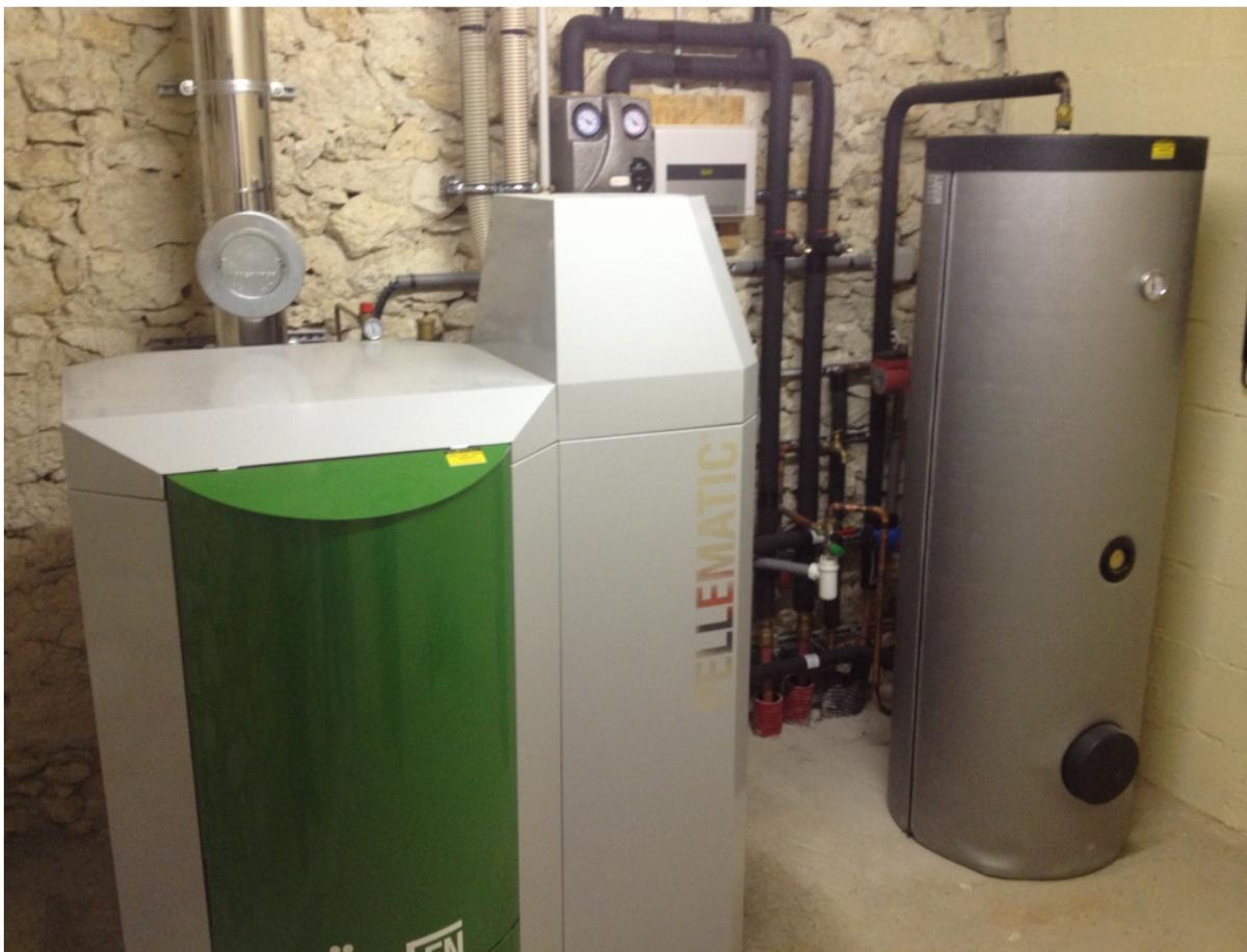
*Chaudière granulés de bois de marque Ökofen d'une puissance de 25 kW en remplacement d'une chaudière fioul. Alimentation automatique par aspiration à partir d'un silo de 6,7 tonnes. Elle assure également la production d'eau chaude sanitaire avec un ballon d'une capacité de 300 litres.*
