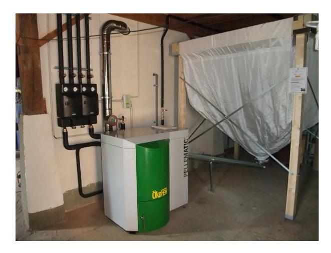
Chaudière granulés de bois de marque Okofen d'une puissance de 20kW en remplacement d'une chaudière fioul. Alimentation automatique par vis à partir d'un silo de 4,5 tonnes. Qualibois RGE
