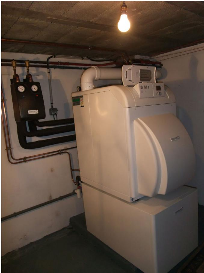
*Chaudière fioul condensation marque Brötje d'une puissance de 26kW, elle assure également la production d'eau chaude sanitaire avec un ballon d'une capacité de 160 litres.*
