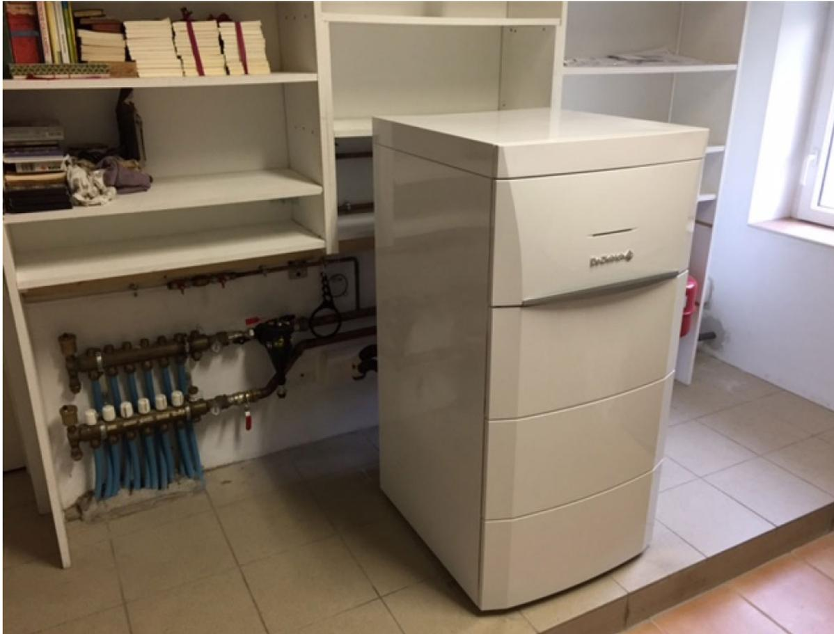
*Pompe à chaleur monophasé air / eau de marque DeDietrich avec un plancher chauffant de 120 m<sup>2</sup> la production ECS 180 litres est assurée par la PAC en thermodynamique.*
