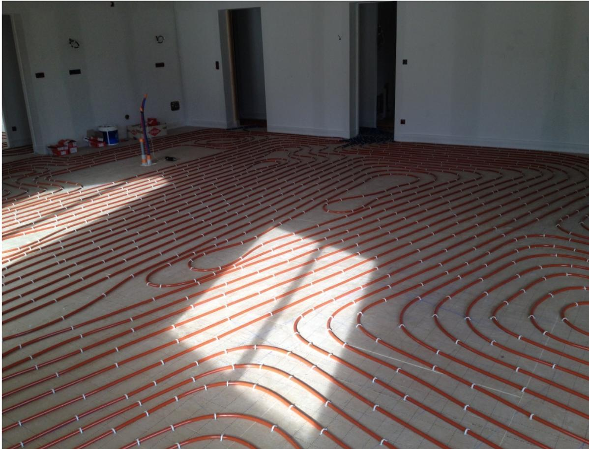
*Ets Vellard Chauffagiste QualiPac RGE Plancher chauffant basse température avec une chaudière électrique Gréтел 12 kw.*
