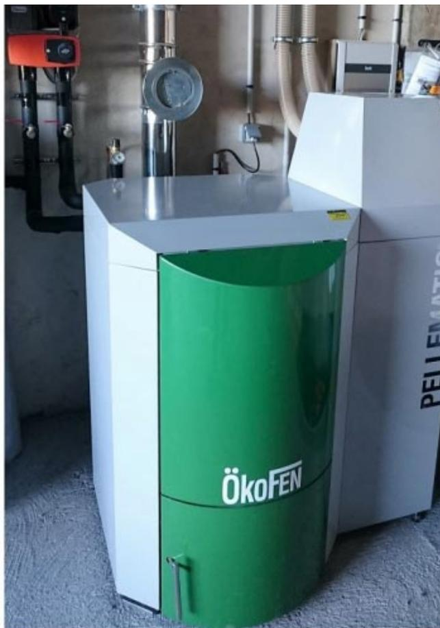
*Ets Vellard Chauffagiste Qualibois RGE. Chaudière granulés de bois Okofen d'une puissance de 20 kW en remplacement d'une chaudière gaz propane dans une maison d'habitation. Alimentation automatique par aspiration à partir d'un silo textile de 7 tonnes.*
