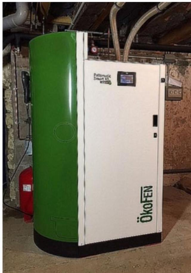
*Ets Vellard Chauffagiste Qualibois RGE Chaudière granulés de bois à condensation Okofen SMART XS, d'une puissance de 3 à 14 kW en remplacement d'une chaudière Gaz Propane. Alimentation automatique par aspiration à partir d'un silo de 5 tonnes. Elle assure également la production d'eau chaude sanitaire instantanée 21 litres/min*
