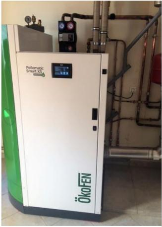
Ets Vellard Chauffagiste Qualibois RGEChaudière granulés de bois à condensation Okofen SMART XS, d'une puissance de 3 à 14 kW en remplacement d'une chaudière Gaz Propane.
