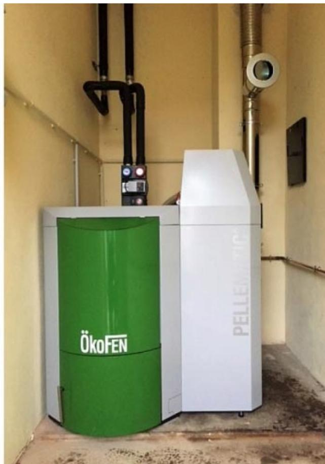
*Ets Vellard Chauffagiste Qualibois RGE. Chaudière granulés de bois Okofen d'une puissance de 20 kW en remplacement d'une chaudière fioul dans un commerce, Bar Tabac Prèsse à LAROQUE TIMBAUT. Alimentation automatique par aspiration à partir d'un silo textile de 8.5 tonnes.*
