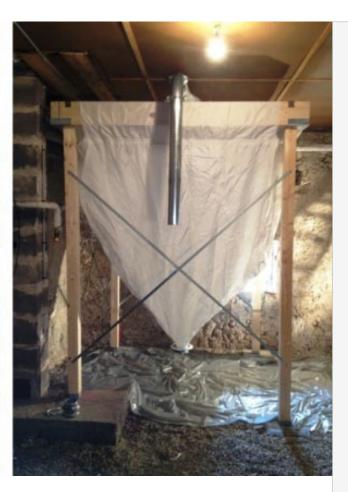
Chaudière granulés de bois de marque Okofen d'une puissance de 20kW en remplacement d'une chaudière fioul. Alimentation automatique par vis à partir d'un silo de 6.6 tonnes.
