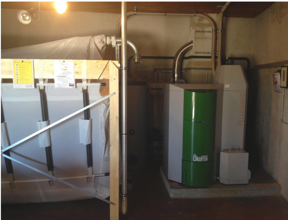
*Ets Vellard Chauffagiste Qualibois RGE Chaudière granulés de bois Okofen d'une puissance de 36 kW en remplacement d'une chaudière fioul.
