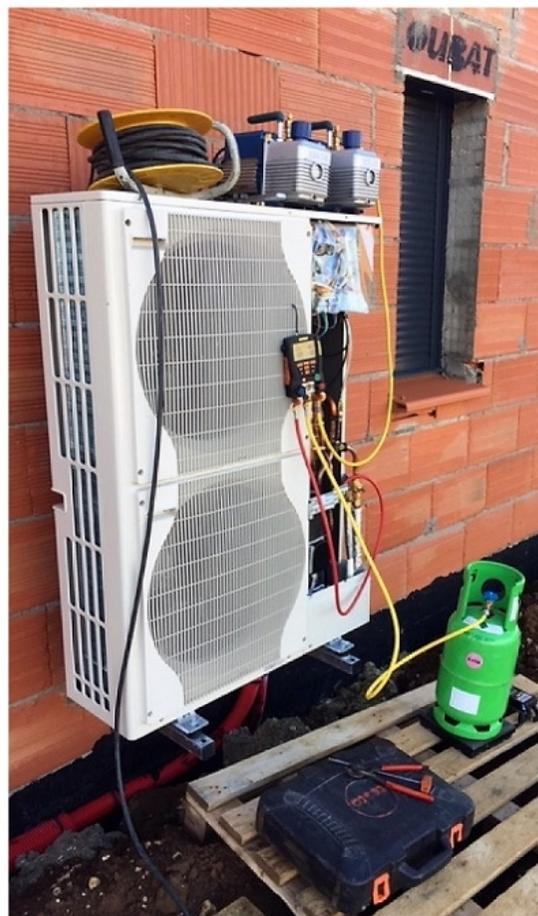
*Installation d'une Pompe à chaleur basse température De Dietrich Alezio avec appoint électrique intégré split inverter air eau, chauffage plancher chauffant 250 m<sup>2</sup> + eau chaude sanitaire 180 litres. Les avantages: gain de place, produit parfaitement adapté à la construction neuve RT 2012. En tant qu'installateur RGE Qualipac, Qualibat nous avons conseillé à notre client la puissance Pac 12 kw.*
