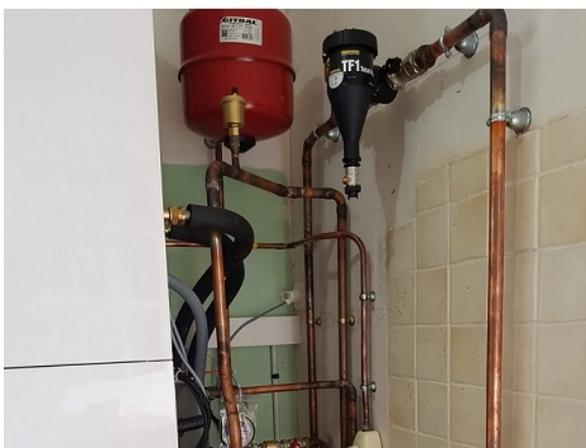
*Ets Vellard Chauffagiste Installation d'une Pompe à chaleur hybride HPI marque De Dietrich avec appoint Gaz condensation intégré split inverter air eau, chauffage radiateurs 120 m<sup>2</sup> + eau chaude sanitaire 180 litres. Les avantages: gain de place, produit parfaitement adapté à la rénovation. En tant qu'installateur RGE Qualipac, nous avons conseillé à notre cliente la puissance Pac 6 kw, Chaudière modulante 15 kw.*
