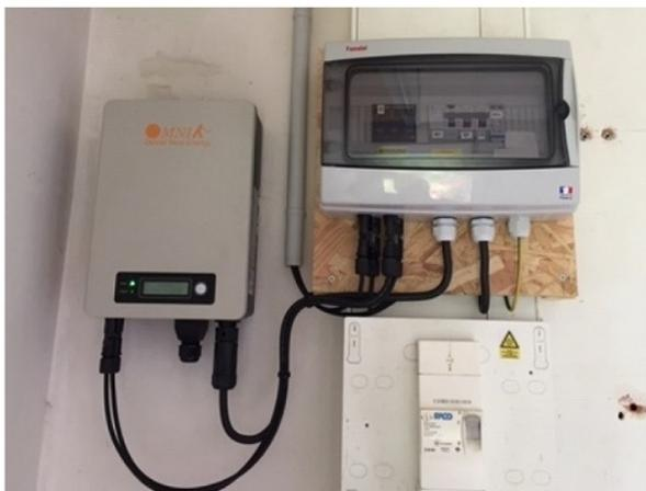
*ETS VELLARD à réalisé une installation photovoltaïque auto consommation 4 panneaux pour une puissance de 1.2 KWc, permettant de réduire la consommation électrique de la piscine l'été, et de la pompe à chaleur Hybride l'hiver. Ce sont des panneaux marque SYSTOVI type V-SYS on top, 300Wc en sur imposition toiture.*
